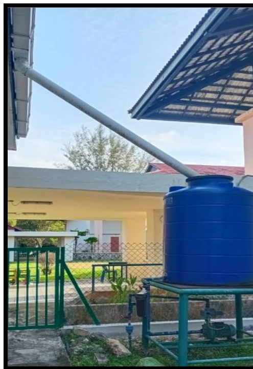
Rajah 7. Sistem Penuaian Air Hujan (SPAH) yang telah dibangunkan di dewan kuliah UMS
