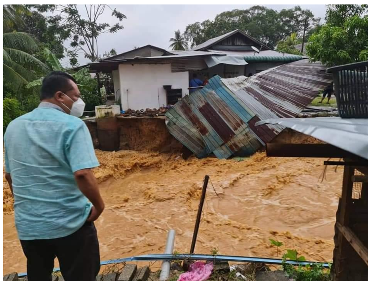
Rajah 1. Kediaman yang rosak akibat hakisan tebing sungai di Kampung Sungai Badak, Gurun Kedah selepas kejadian banjir kilat dan kepala air.
