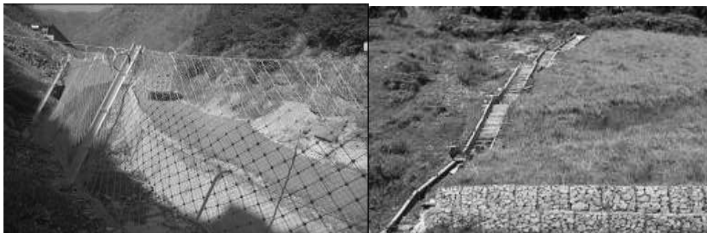
Gambar 1 Penggunaan kaedah Ring Net Barrier dan Cascading drain
