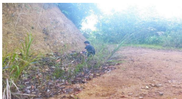
Rajah 4: Proses pembinaan jalan raya
