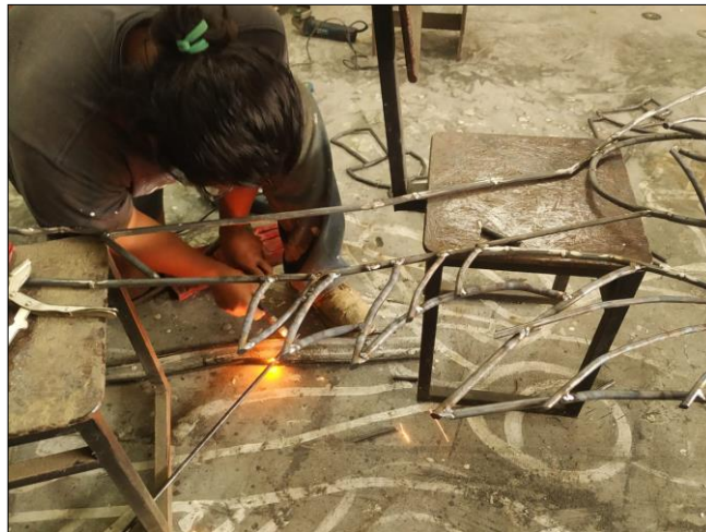
Rajah 5. Proses mencantumkan besi menggunakan mesin welding MIG
