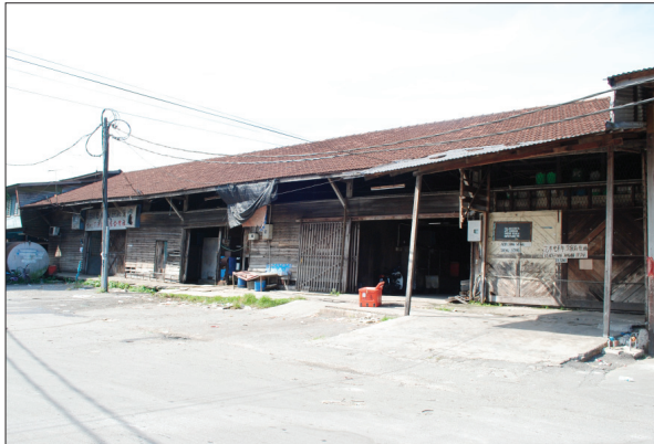
Rajah 4 Bangunan gudang Keretapi Tanah Melayu (KTM) yang berubah menjadi gudang pendaratan ikan di laluan lama kereta api di Pekan Port Weld (Kuala Sepetang).
